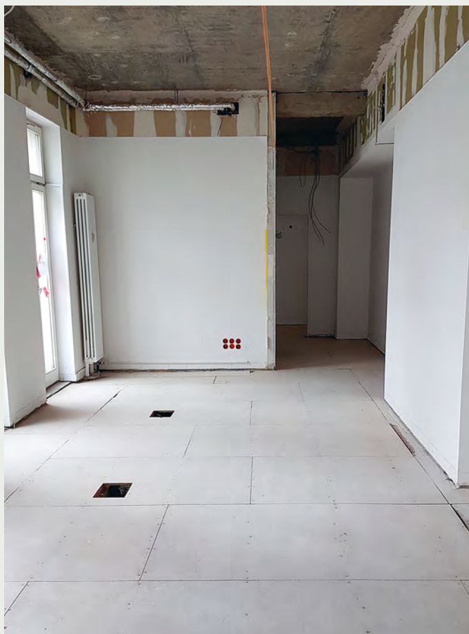
Umbau der 4. Etage des DeZIM-Instituts. Bild oben: Büro im vorderen Teil. Bild unten links: Co-Working Space im hinteren Teil. Bild rechts: Cafeteria im Verbindungstrakt
